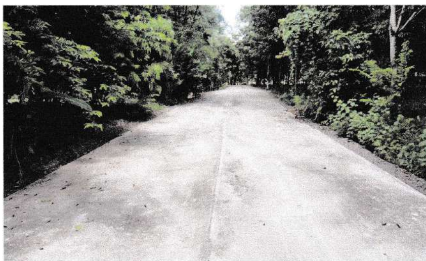
๑๕. โครงการก่อสร้างถนนคอนกรีตเสริมเหล็ก บ้านเทพอุดม หมู่ที่ ๑๑ สายโคกระกา
